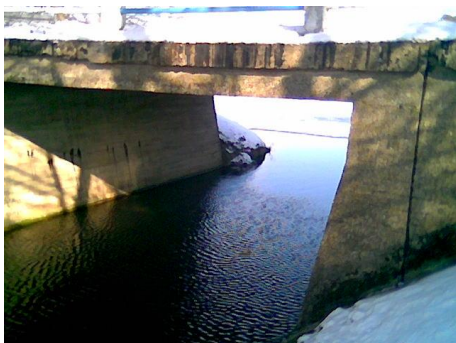
Fot. 20. Przesmyk pomiędzy Jez. Somińskim i Jez. Dywan
