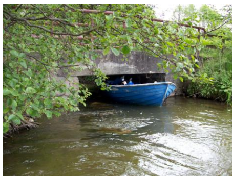
Fot. 10. Mostek przed Jez. Patulskim
