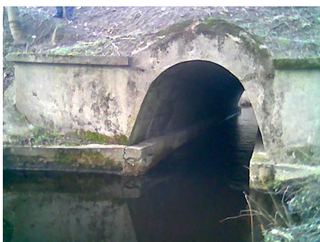
Fot. 13. Kanalik pod mostem przed Jez. Obrowo
