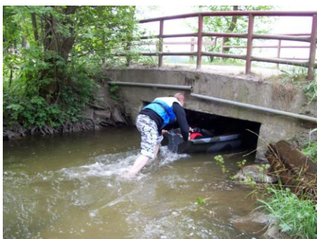
Fot. 9. Mostek przed Jez. Patulskim
