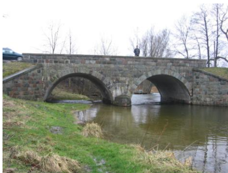
Fot. 6. Most na kanale pomiędzy Jezioremi Wielkie i Małe Brodno
