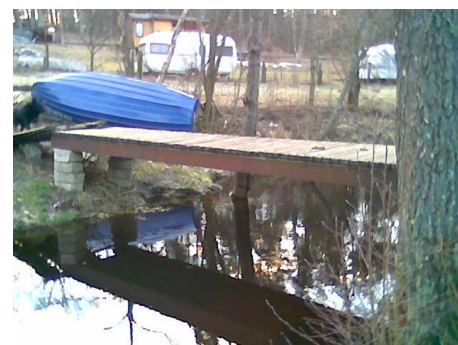
Fot. 14. Kładka na kanale łączącym Jeziora Jasień i Obrowo
